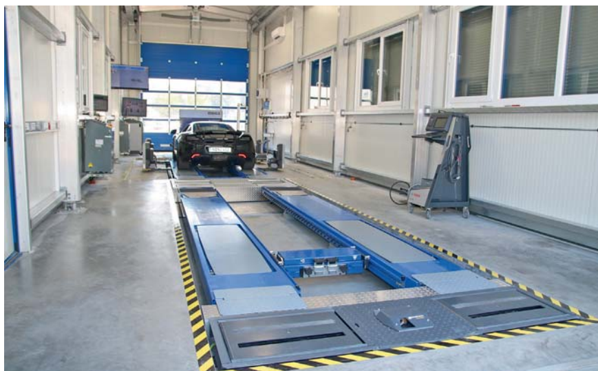
Blick in die Halle: Die Anordnung der Prüfmodule erlaubt die schnelle Vermessung eines Fahrzeugs.
