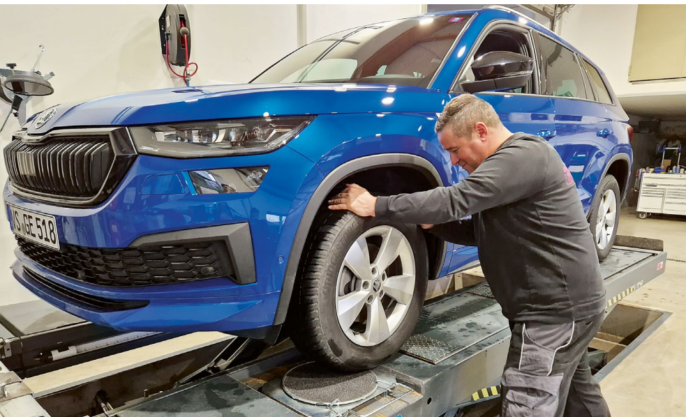
Bei der Achsvermessung ist eine nivellierte Hebebühne mit einstellbaren Drehtellern ideal.
