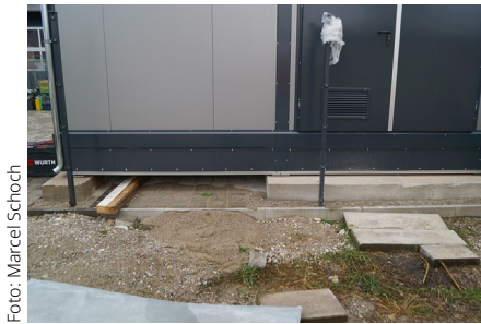
Jederzeit umzugsbereit: Die einzelnen Module ruhen lediglich lose auf den Fundamenten.
