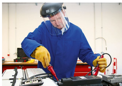
Nur mit persönlicher Schutzausrüstung: Die offene Batterie steht unter Spannung.
