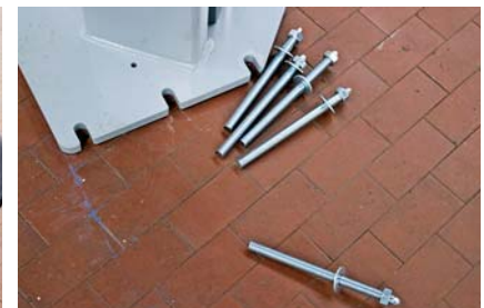
Schritt 6: Die Bodenanker werden auf die erforderliche Länge zugeschnitten und versenkt.
