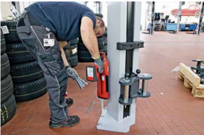
Schritt 7: Vorher werden die Bohrlöcher noch mit speziellem Injektionsmörtel aufgefüllt.
