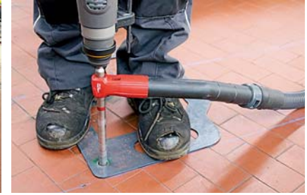
Schritt 3: Das Bohren der Löcher für die Bodenanker erfolgt mittels Schablone, mit Absaugvorrichtung für den Bohrstaub.
