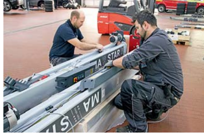
Schritt 2: Vorbereitung der zweiten Bedieneinheit, die von Autohaus Schall gewünscht war. Alle Kabel sind steckbar.
