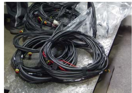
Weil das System autark arbeitet, sind dafür viele Kabel und Leitungen zu verlegen.
