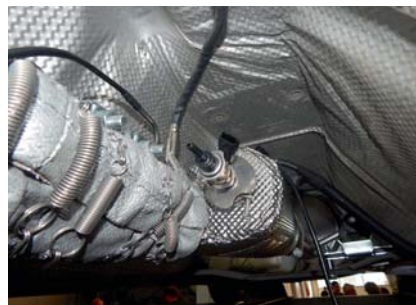
Die AdBlue-Einspritzdüse wird im Generator eingebaut und angeschlossen.
