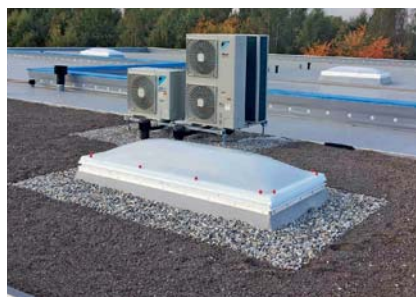
Heizt im Winter und kühlt im Sommer: Die Wärmepumpe im Bereich des Gründachs wird mit Strom aus der eigenen PV-Anlage versorgt.
