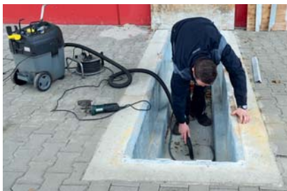
Bevor es losgehen kann, muss Schmutz und Laub aus der Einbauwanne entfernt werden.
