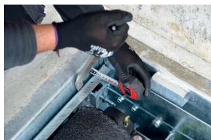
Zentimetergenau wird der Prüfstand im Fundament ausgemittelt.
