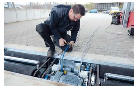
Die Kabel werden entwirrt, an einem Durchzugsband befestigt und nach innen gezogen ...
