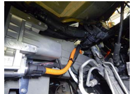
Das 230-Volt-Kabel wird von der Heizung zum gewünschten Anschlussort verlegt.
