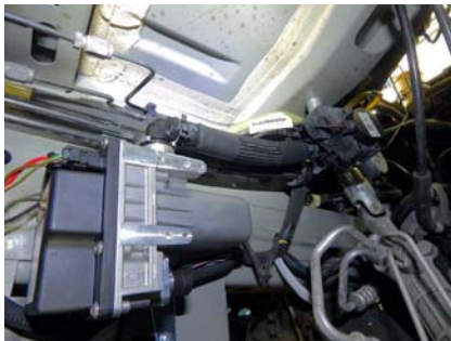
Heizaggregat und Kühlmittelpumpe werden montiert und verbunden ...
