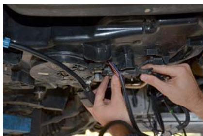
Pumpe und Heizung des Tanks sowie diverse Sensoren müssen angeschlossen werden.
