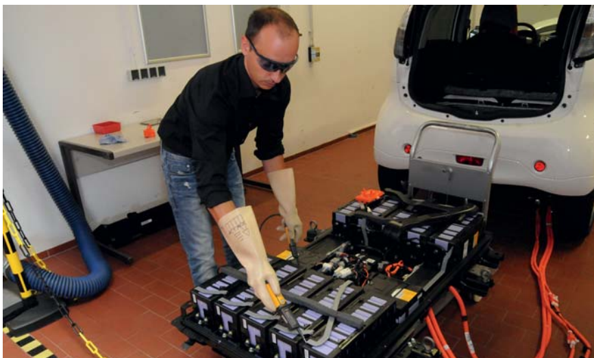
Selbst im entladenen Zustand enthalten die Zellen in der Summe immer noch um die 300 Volt.
