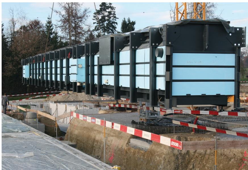
Nussbaum bietet komplette vorgefertigte Wannen an. Sie sind auf Dichtheit bereits ab Werk geprüft.
