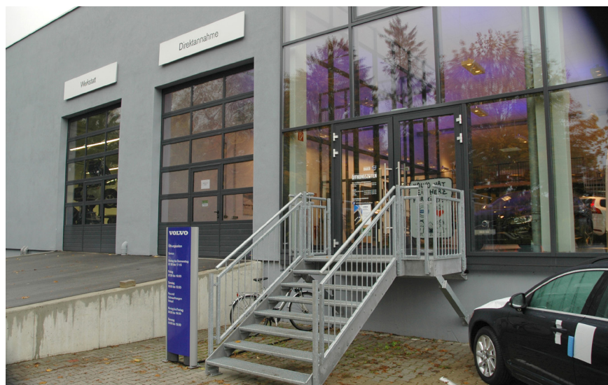
Die Direktannahme befindet sich in Regensburg direkt neben dem Schauraum – verglaste Seiten sorgen für Transparenz.
