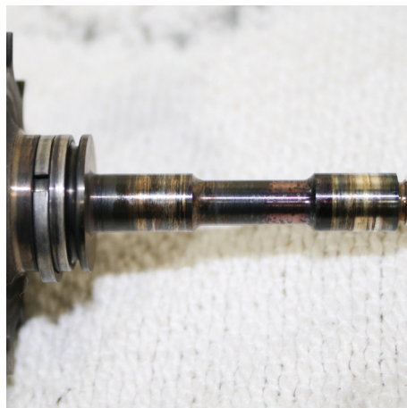
... die Lagerstellen der Läuferwelle sind durch Ölmangel verschliffen/beschädigt,...
