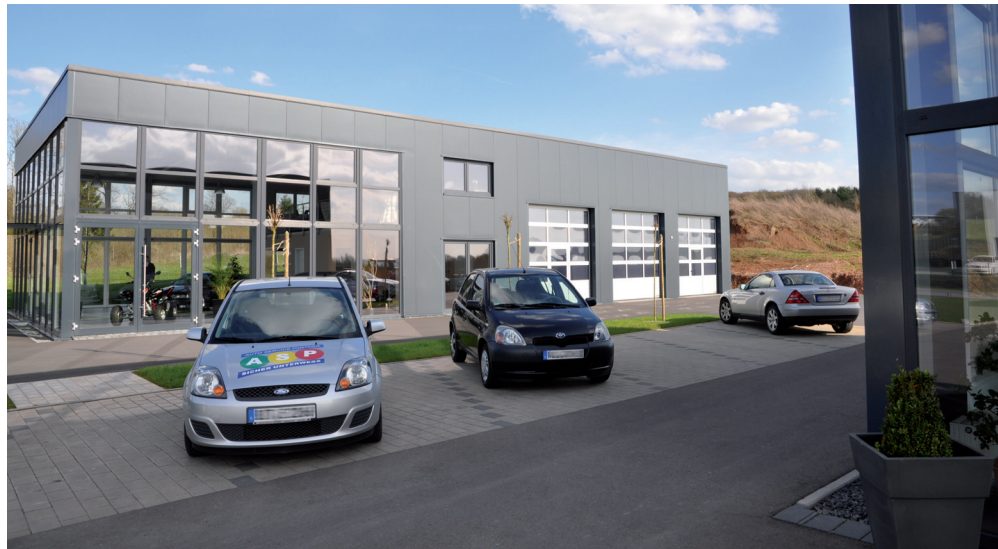
Bauabschnitt 2 beherbergt die verglaste Ausstellungshalle mit Büros. Zudem entstand ein Diagnosearbeitsplatz sowie eine Fahrzeug-Pflegehalle. Die Baugrube im Hintergrund markiert den Standort einer der geplanten Betriebsleiterwohnungen
