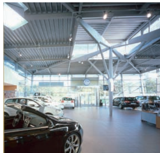
Schirmstütze nennt man die Hallenkonstruktion im Fachjargon der Autohausplaner
