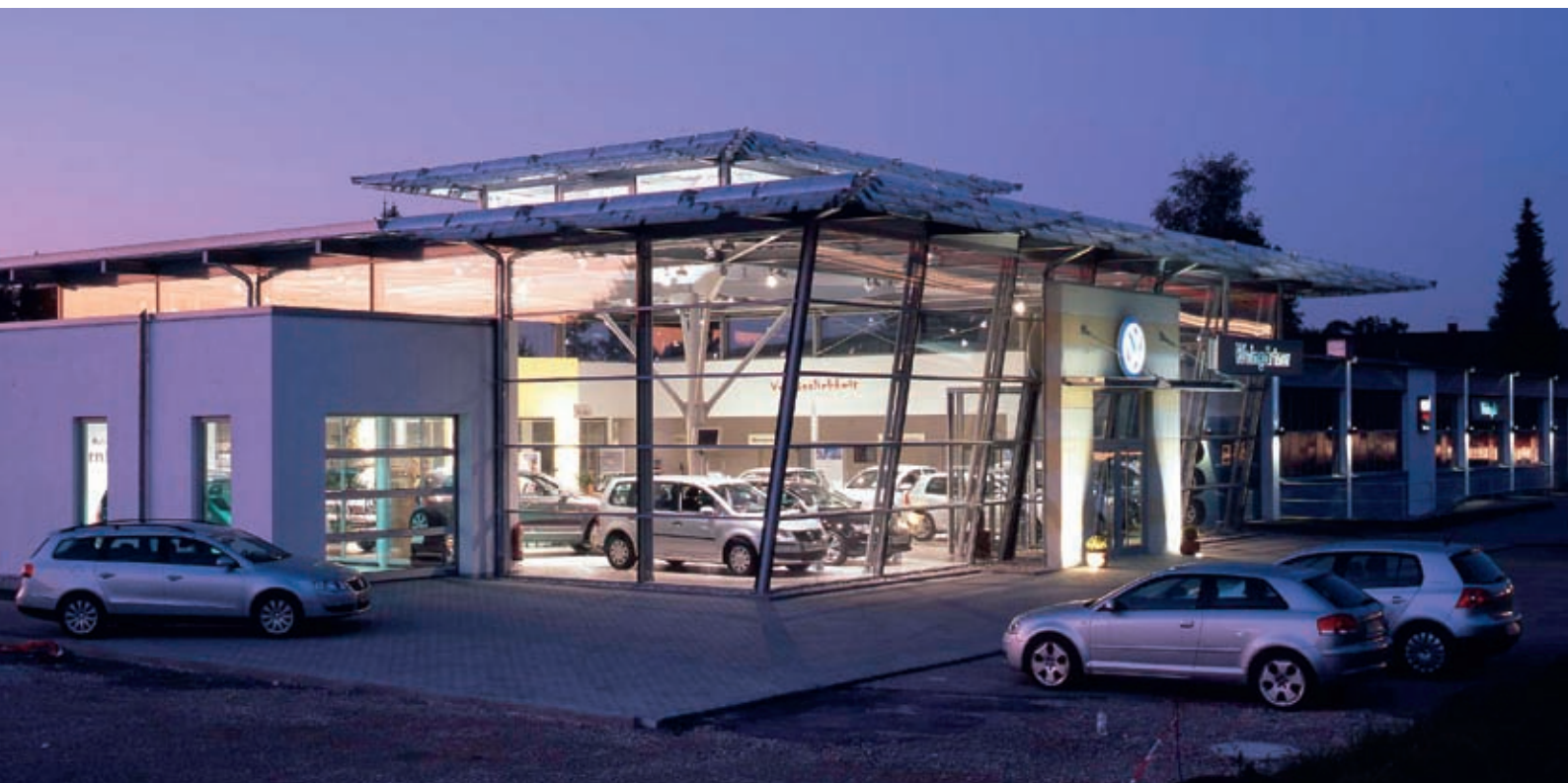
Die schräge Glasfassade mit der Schirmstütze in der Mitte verleiht der Ausstellungshalle ein filigranes Aussehen
