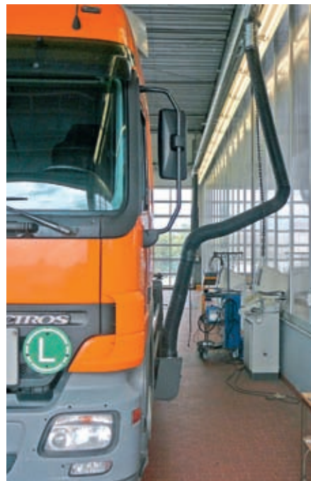
Beim SLS Truck-Lift, der für die AU geeignet ist, kommen kräftigere Abgasschläuche zum Einsatz
