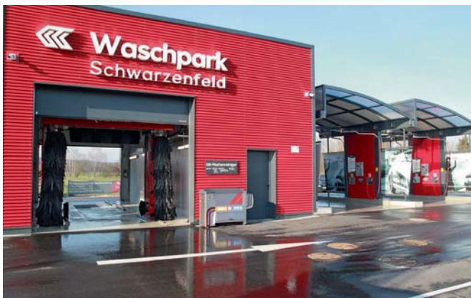
Hereinspaziert: Seit dem 23. Oktober 2015 stehen Portalanlage und SB-Waschplätze von WashTec den Kunden zur Verfügung.
